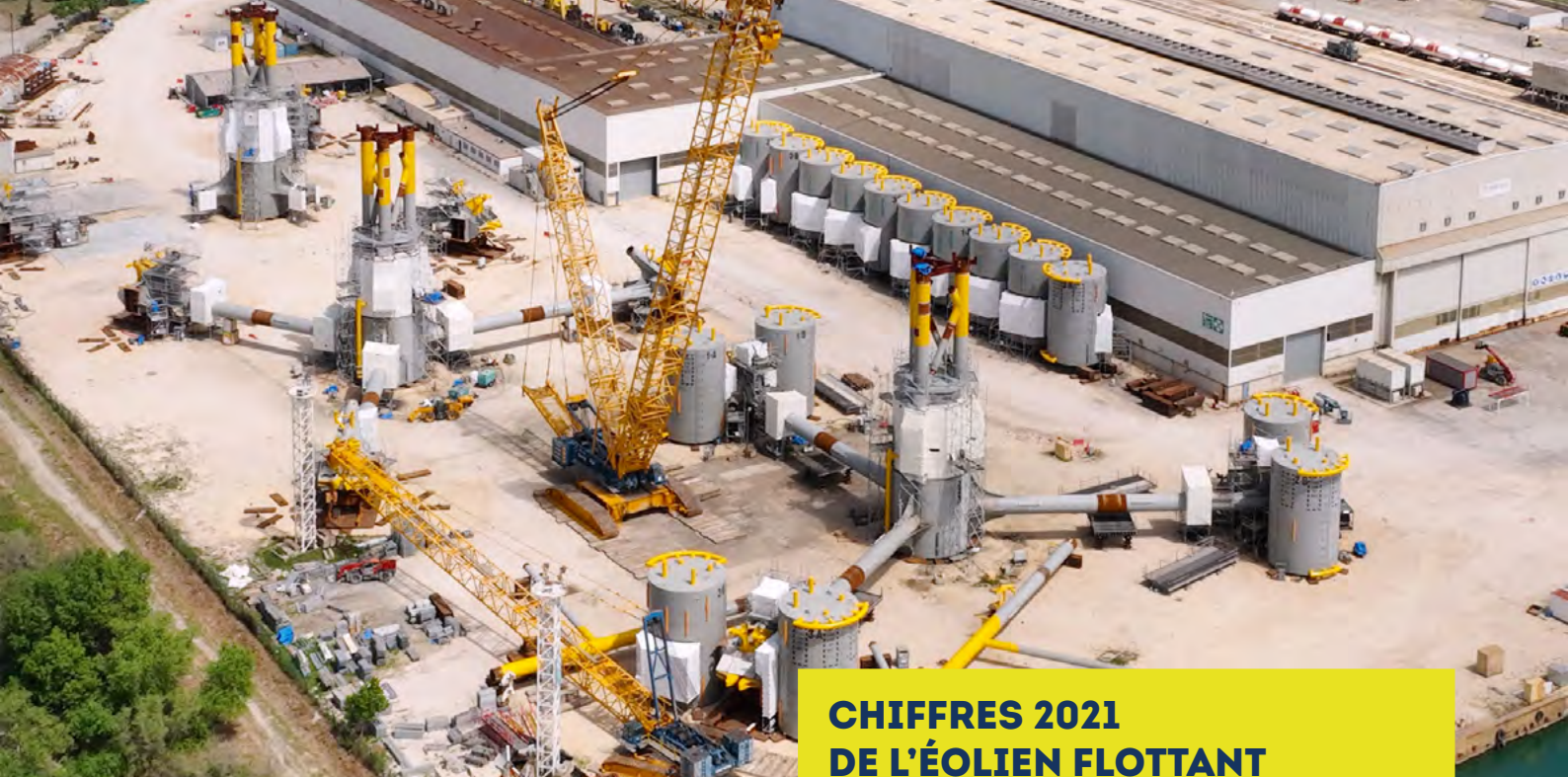
Fabrication des flotteurs pour la ferme pilote Provence Grand Large par Eiffage Métal à Fos-sur-Mer - ©Eiffage Métal
